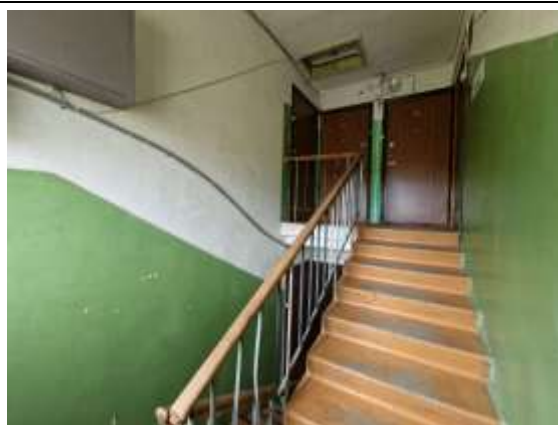
5.stāva kāpņu telpa
